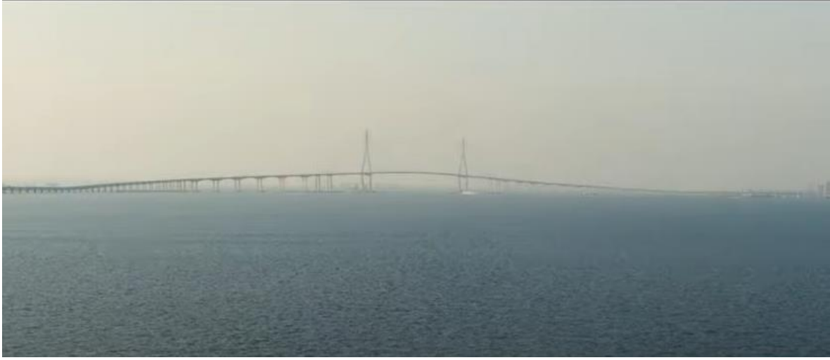
Şekil 5. Deniz üzerinde uzun köprü
